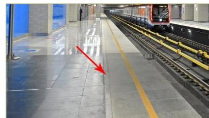
*Рисунок 9.5 Предупреждающая шлицы на платформе метро*
