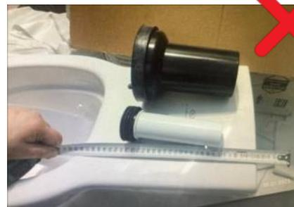
Рисунок 9.2. Короткие присоединительные патрубки стандартной инсталляции
