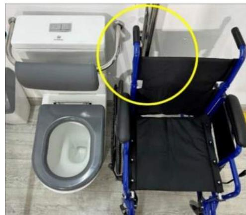
*Рисунок 7.2.5. Откидной поручень в поднятом положении не мешает боковому размещению коляски.*
