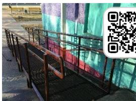
[«Классик» - настил из ПВХ, поручни из конструкционной стали, арт. 2285](#)
