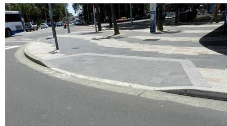
Рисунок 14. Бордюрный пандус с наклонными примыкающими плоскостями
